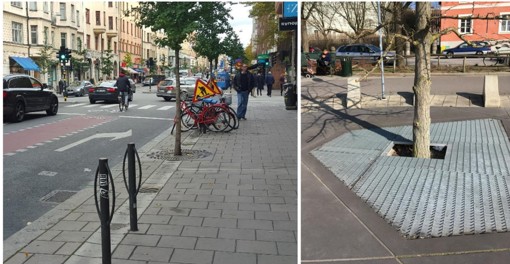
Figur 17. T.V. Exempelbild på trädgrop där vattnet avvattnas via rännor för trottoar till trädgrop och dagvattenbrunn från gata (Ramboll). T.H. Nedsänkt trädgrop med markgaller (Ramboll).
