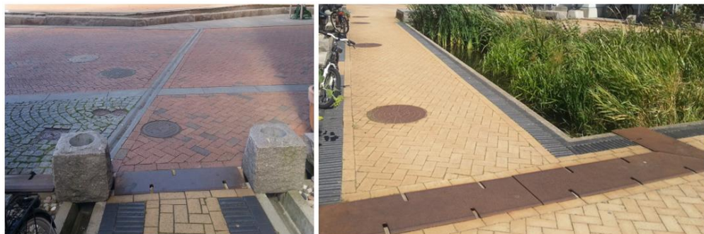
Figur 20. Exempel på rännor över gatusektion (Ramboll).
